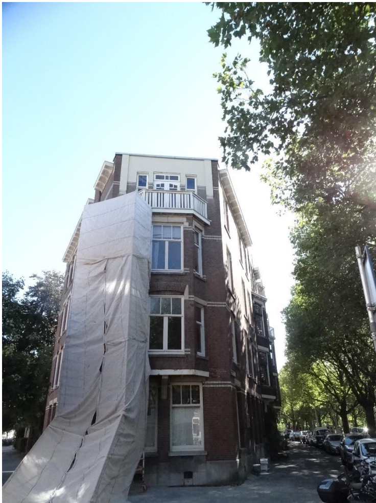
Overzicht foto waarbij men een reparatie uit voert bij de oplegging ter plaatse van het balkon.
